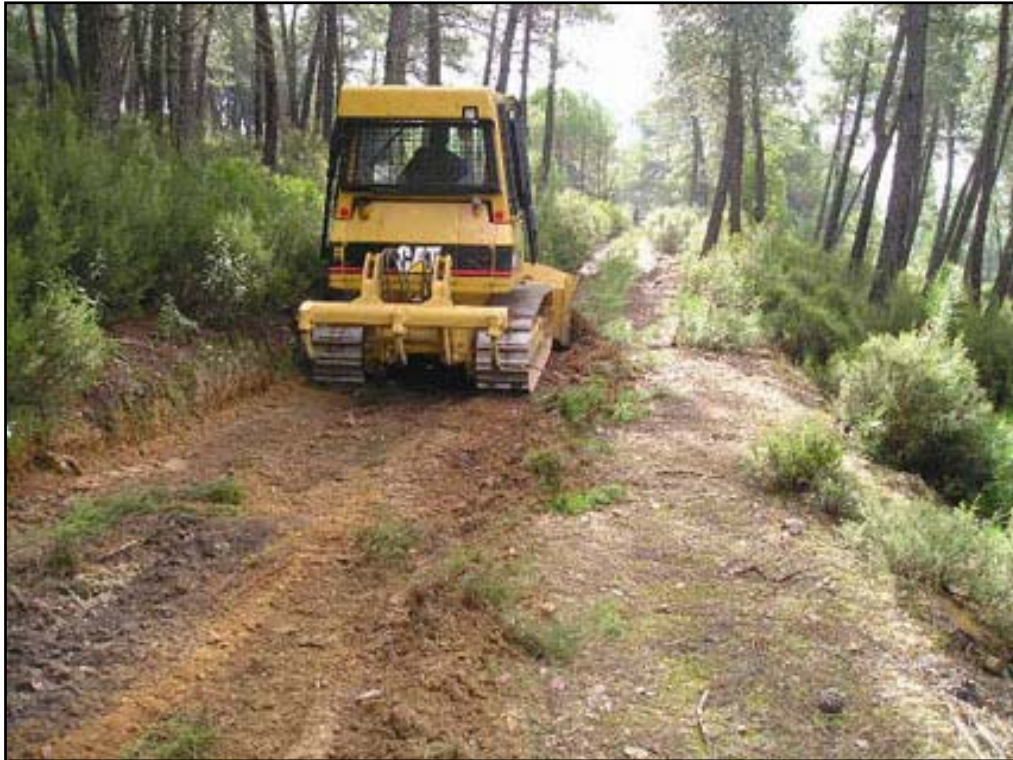
Buldozer arreglando una pista en Herrera del Duque
