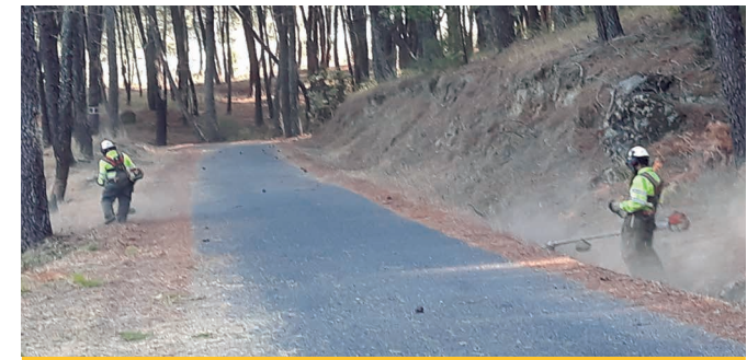
Trabajos con motodesbrozadora
